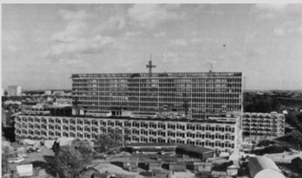
Bouw van het Reyerscomplex in 1970, in: RTB, Le point d'interrogation , februari 1971, blz.2.
