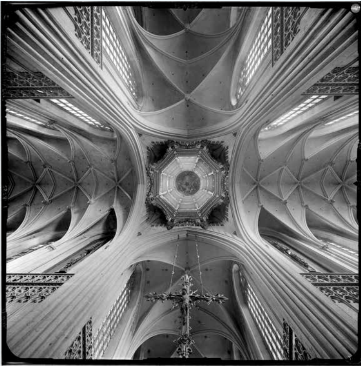
Fig. 4: Koepel van de Onze-Lieve-Vrouwekathedraal van Antwerpen, op 13 oktober 1917 gefotografeerd door het Instituut voor Fotogrammetrie van Berlijn, onder leiding van Theodor von Lüpke. De fotograaf kon de platencamera kantelen dankzij een scharnierend tussenstuk dat tussen het statief en de camera was geschroefd. Dit adembenemende gezicht op de gewelven van het transept is perfect gecentreerd: de ijktekens (hier een enkel stipje in het midden van elke zijde) hebben de fotograaf in staat gesteld om de exacte positie in het midden van het transept te verifiëren. © KIK-IRPA, Brussel, 1917, F000036.
